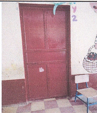
Remozamiento de puertas
