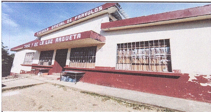
Pintura en muro exterior
