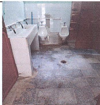
Cambio de azulejo en los baños, puertas, drenaje, arreglo de instalación.
